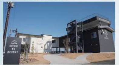
防潮堤の外側に建設された、「常識破り」のシチノリゾート。堤防より高い位置に客室を用意、屋上に避難デッキを作るなど、安全性をしっかりと確保している
