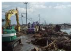
荒浜原野線施工の様子
