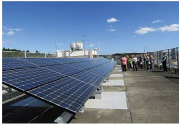
今年度すべての指定避難所等200か所に設置が完了する太陽光発電と蓄電池、停電時には非常用電源として使用可能。また、学校での防災教育の推進はもとより、女性、子ども、若者、障害者の視点を反映した防災対策など防災環境「ひと」づくりに積極的に地域住民と取り組んでいる
