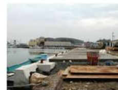
津波被害を受けた仙台臨海港(吉田花洲)の復旧とともに、防波堤をかさ上げすることで国際海上輸送網の防災機能を向上することも行われている
