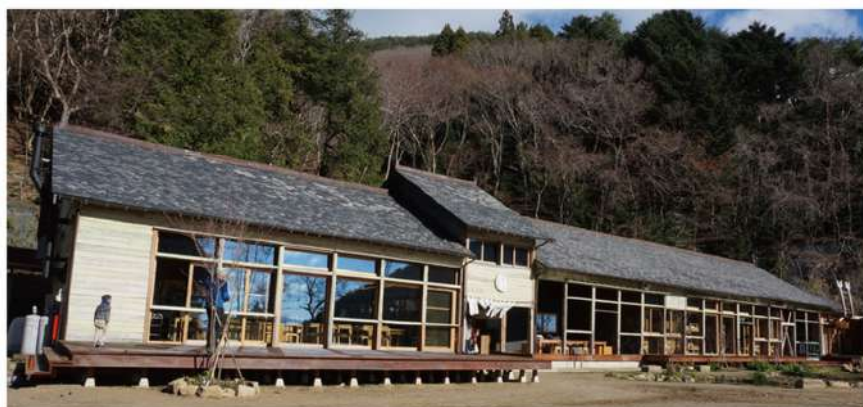
雄勝湾を見下ろす高台に建つ、雄勝硯を使ったスレート屋根が特徴的な美しい佇まいの木造校舎
