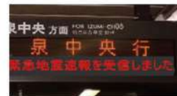
震度5以上の地震が予測される場合に、地下鉄駅構内に、報知音とともに緊急地震速報が流れる。改札及びホーム側に設置している可変表示器にも表示される
