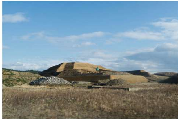
町のいたるところで見られる盛り、がれきで埋め尽くされた場所を整備し、さらに10mを超える盛りを行い、今後はかさ上げした道路の整備などが予定されている。5年たった被災地の今を感じる風景のひとつだ
